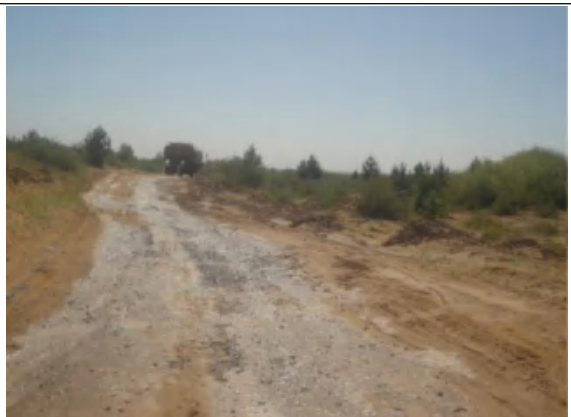
施工道路洒水降尘
