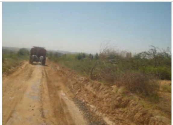
施工道路洒水降尘
