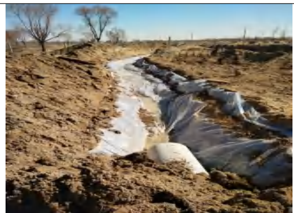
预埋涵管重建灌溉系统
