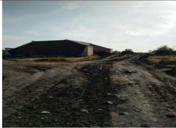
施工道路硬化处理
