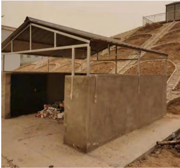
转水庙站垃圾池
