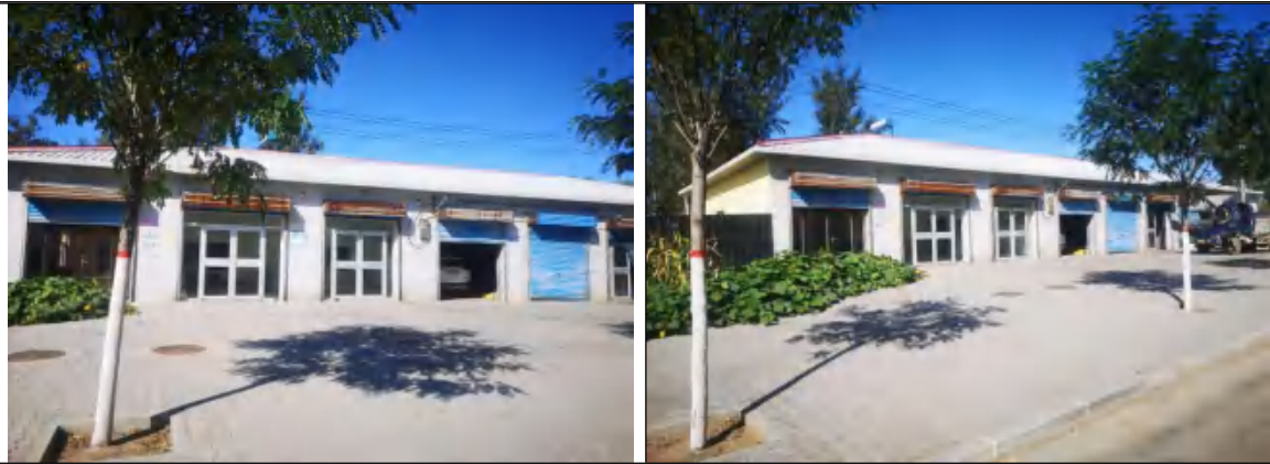
中铁十一局项目部（租用当地民房，已撤离）
