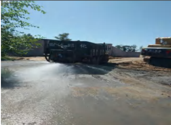
施工道路洒水降尘
