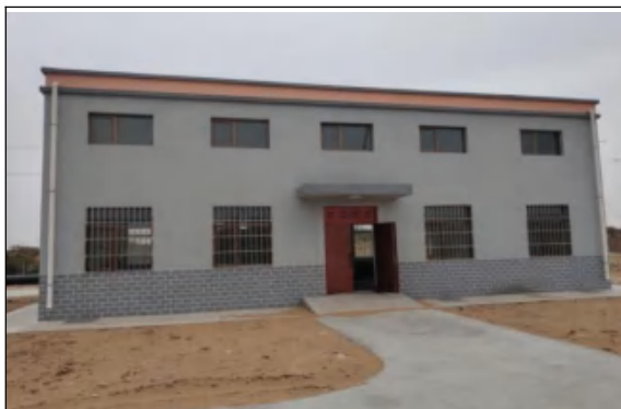
转水庙污水处理间
