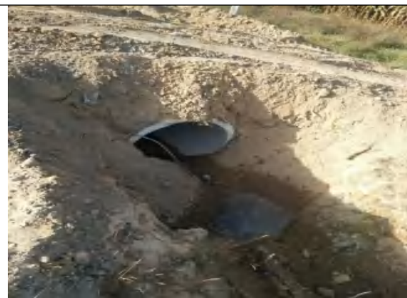
预埋涵管恢复排水系统
