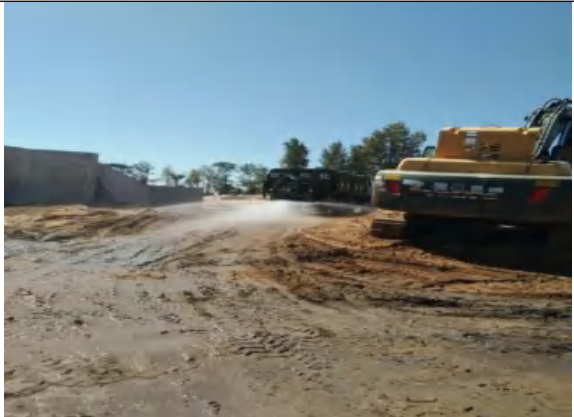
施工道路洒水降尘
