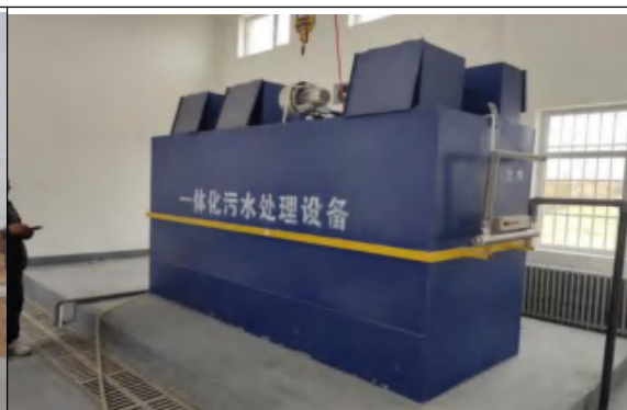
MBR 一体化污水处理设施
