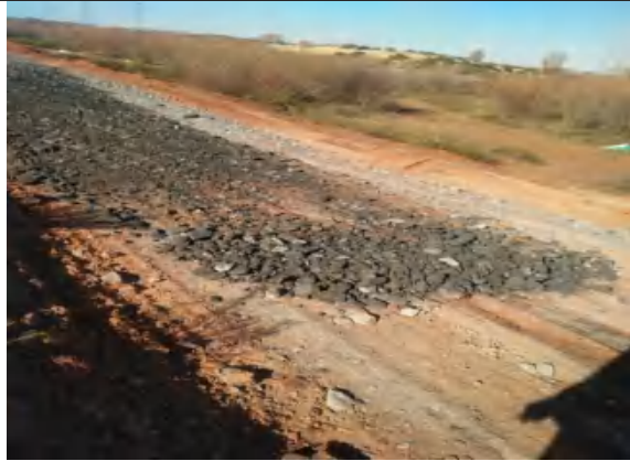
施工道路硬化处理
