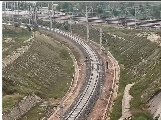
铁路专用线两侧骨架护坡及植被恢复
