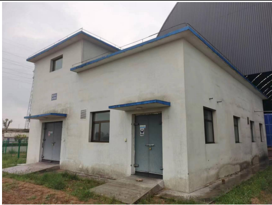
受煤工业场地煤泥水处理站
