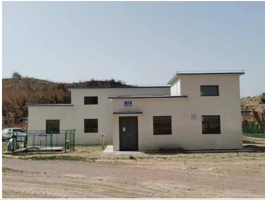
受煤工业广场生活污水处理站
