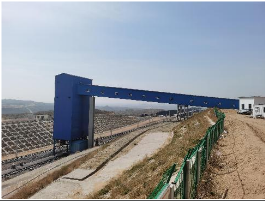
火车快速装车系统设备密闭安置
