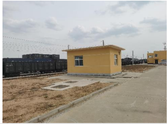
物流站生活污水处理站
