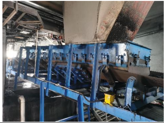
落煤点密闭措施
